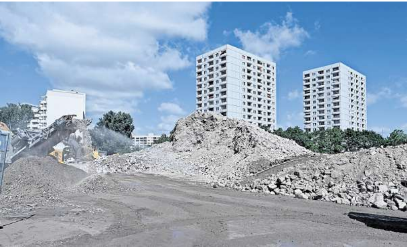
An der Boxberger Straße laufen Abrissarbeiten. Bald entsteht hier das neue BSZ für Elektrotechnik.
