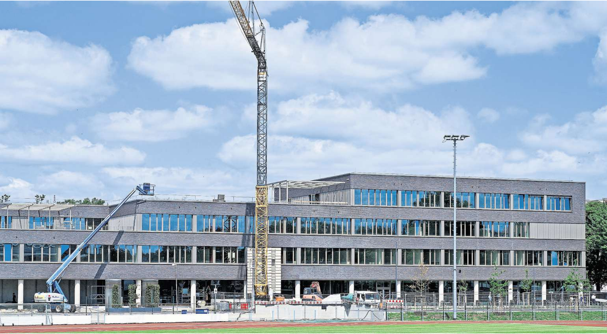
Der Neubau für das LEO-Gymnasium an der Bodenbacher Straße wird bis zu 900 Schülern Platz bieten.
