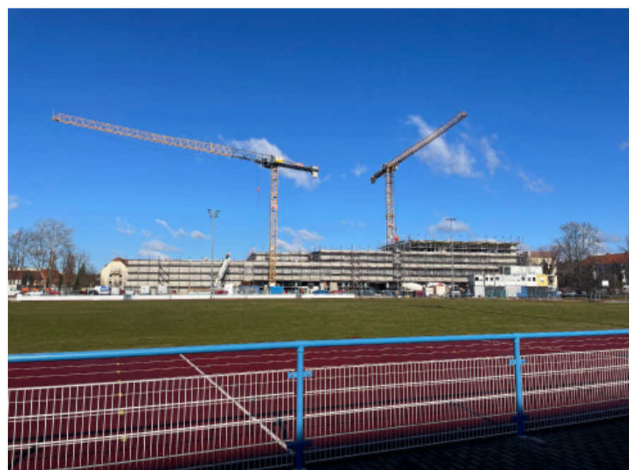
Die letzte Decke wird betoniert
