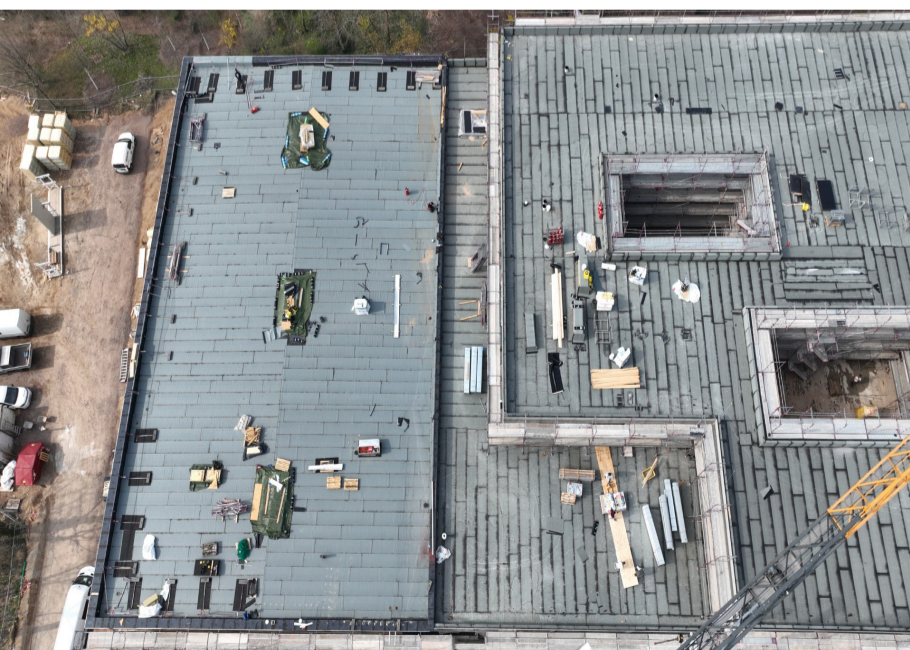
Luftbild mit Blick auf Dachkonstruktion der Sporthalle und Übergang zum Schulhaus
