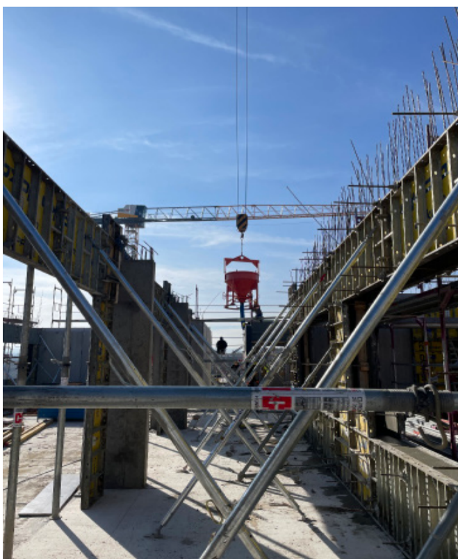
Betonage im 3. OG:
