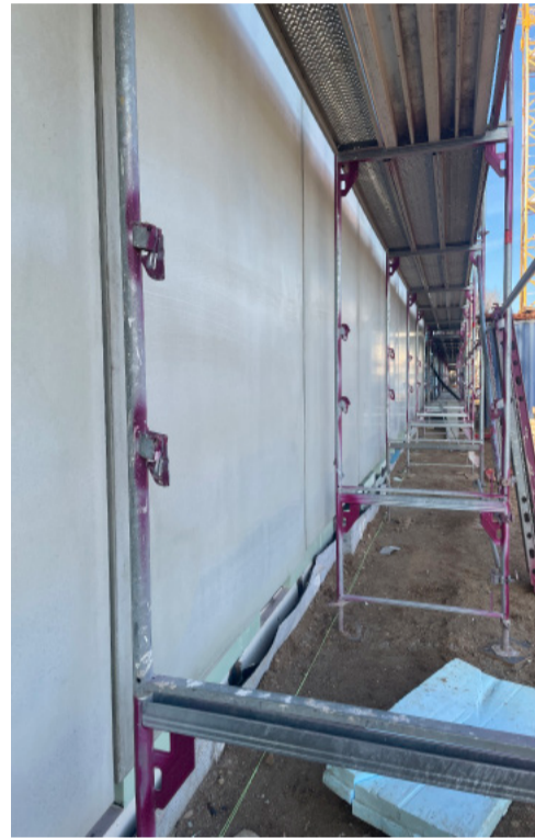
Montage der Sichtbetonfassade
