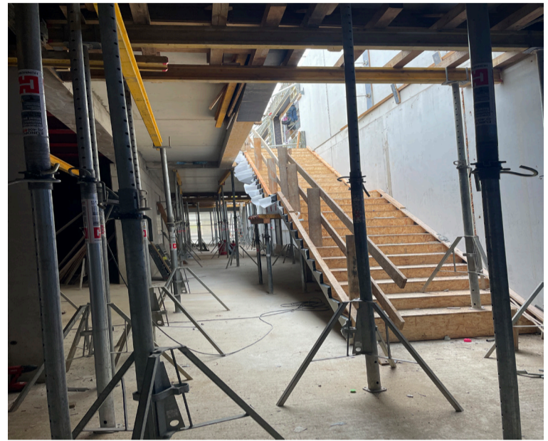
Treppe im Forum:
